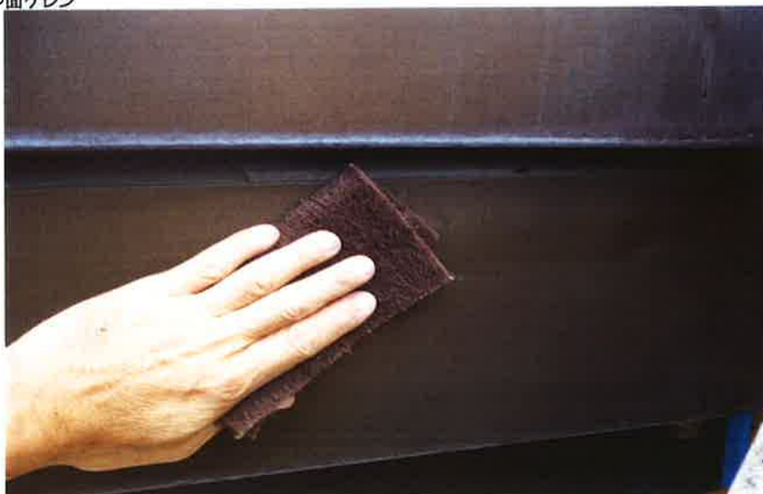
エントランスパネル面ケレン
