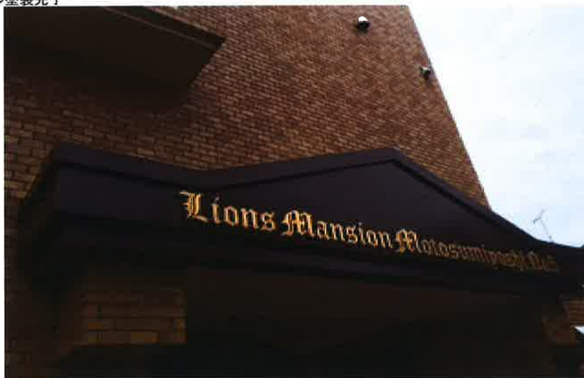
エントランスパネル塗装完了
