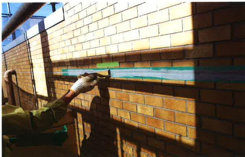
打継目地シール充填完了
