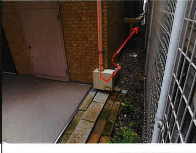
交換する電源ケーブル ルート写真④
