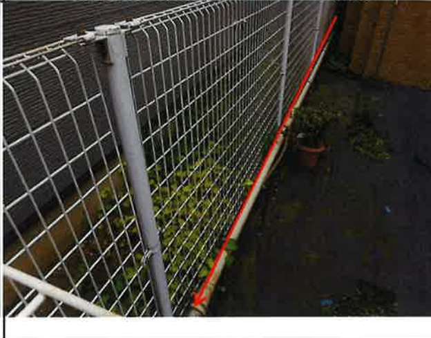
交換する電源ケーブル ルート写真⑥
