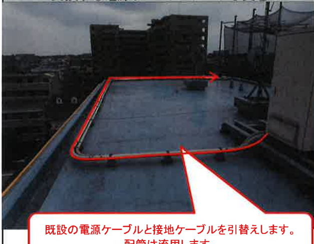
交換する電源ケーブル ルート写真①
