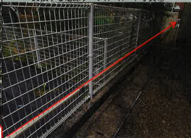
交換する電源ケーブル ルート写真⑥
